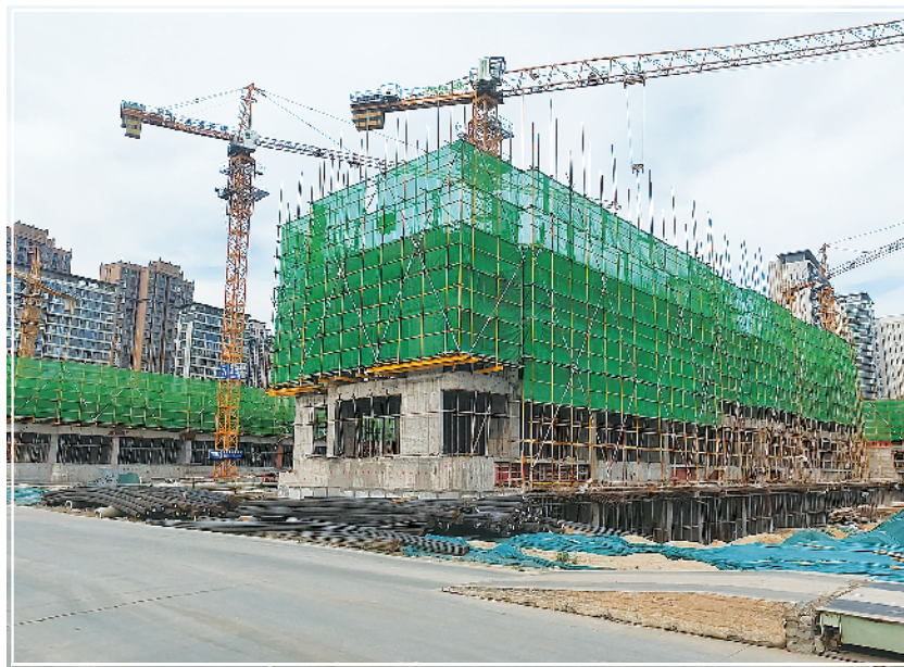
周口志成天境项目施工现场。
