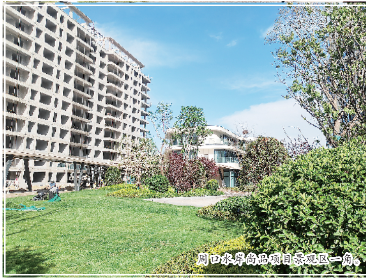
周口水岸尚品项目外景分外夺目。
